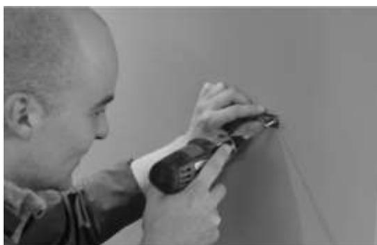
b\_ Rilevati i punti sul muro, procedere con la foratura, l'inserimento dei tasselli e il fissaggio delle squadrette.
