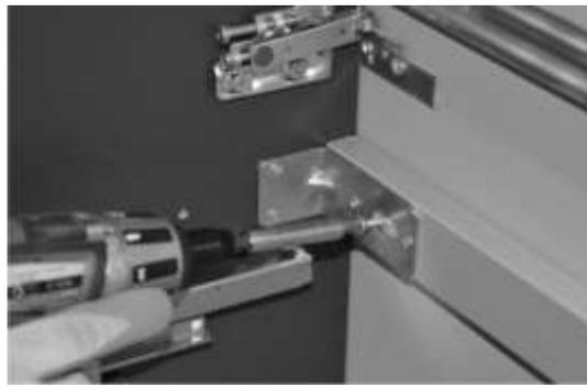
e\_ Dopo aver fissato il mobile con le attaccaglie, si procederà al fissaggio sicuro dello stesso con le viti e tasselli in dotazione sulla catena posteriore del mobile.
