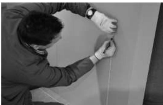
c\_ Rilevate tutte le misure necessarie, procedere con la segnatura sul muro i punti per la foratura e l'inserimento dei tasselli in dotazione (o quelli adatti al vostro muro).
