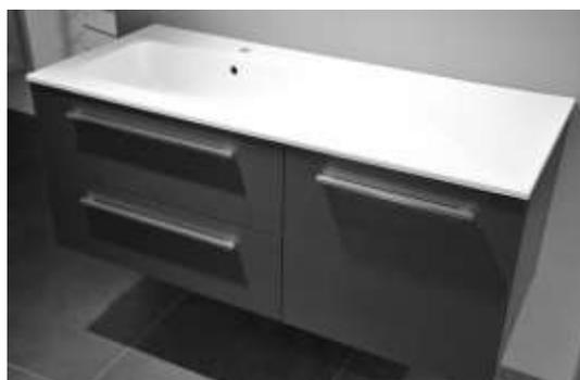
e\_ Una volta verificato le perfette condizioni del mobile e della installazione, procedere con la siliconatura del top facendo attenzione ad utilizzare silicone neutro.
