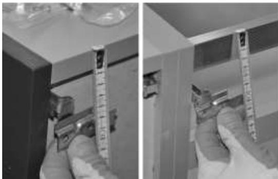
a\_ Per il posizionamento delle squadrette a muro tenere in considerazione che l'altezza per una base contenitore (fig. 1) è diversa da una base lavabo (fig. 2).
