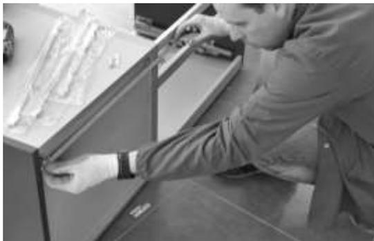
b\_ Le squadrette vanno poste all'interno dei fianchi degli elementi, per cui prestate attenzione nel rilevare con esattezza le misure.
