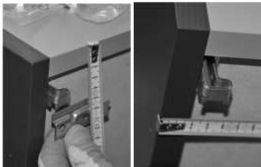
a\_ Per il posizionamento delle squadrette a muro tenere in considerazione la posizione rispetto all'elemento.
