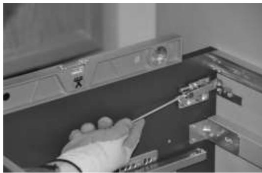
d\_ La messa in bolla sulla profondità del mobile viene fatta agendo sulla vite di tiraggio dell'attaccaglia, come in figura.
