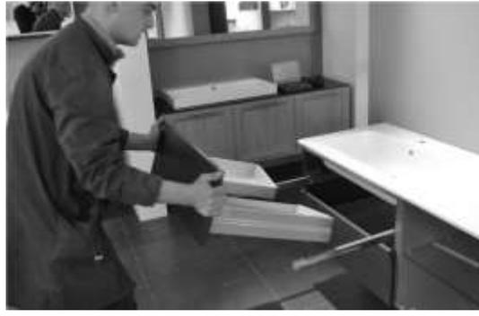
f\_ Dopo aver fissato il mobile al muro, rimontare i cassetti. L'operazione viene eseguita estraendo del tutto le guide, posizionando il cassetto sopra di esse e chiudendo il cassetto.
