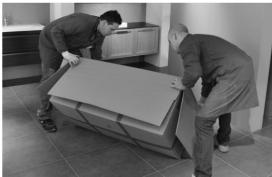
b_ Capovolgere ora l'elemento lasciando aperta la parte inferiore al fine di sfilare l'imballo.
