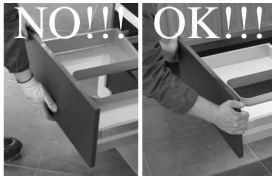
e_ Togliere i cassetti per facilitare l'operazione di fissaggio a muro del mobile.
